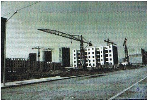
Fig. 2. Bloc de pisos Passeig Espronceda en construcció. Imatge de l'exposició "25 años de paz". Sabadell, 1964. Autor: desconegut /AHS_B010103_D01_00110_037
